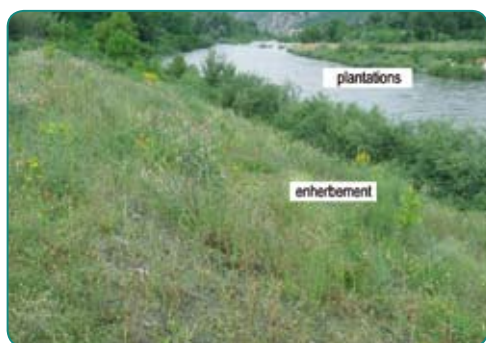
Protection de berge en génie végétal
